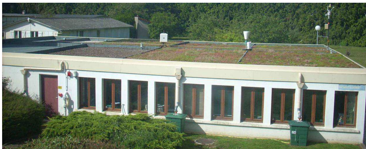
Figure 9 : Toiture végétalisée du CETE IF à Trappes. A droite du toit se trouve la station météo, à gauche de cette station, le pluviomètre. Les bacs verts au pied du bâtiment contiennent les augets pour la mesure des débits de ruissellement.
