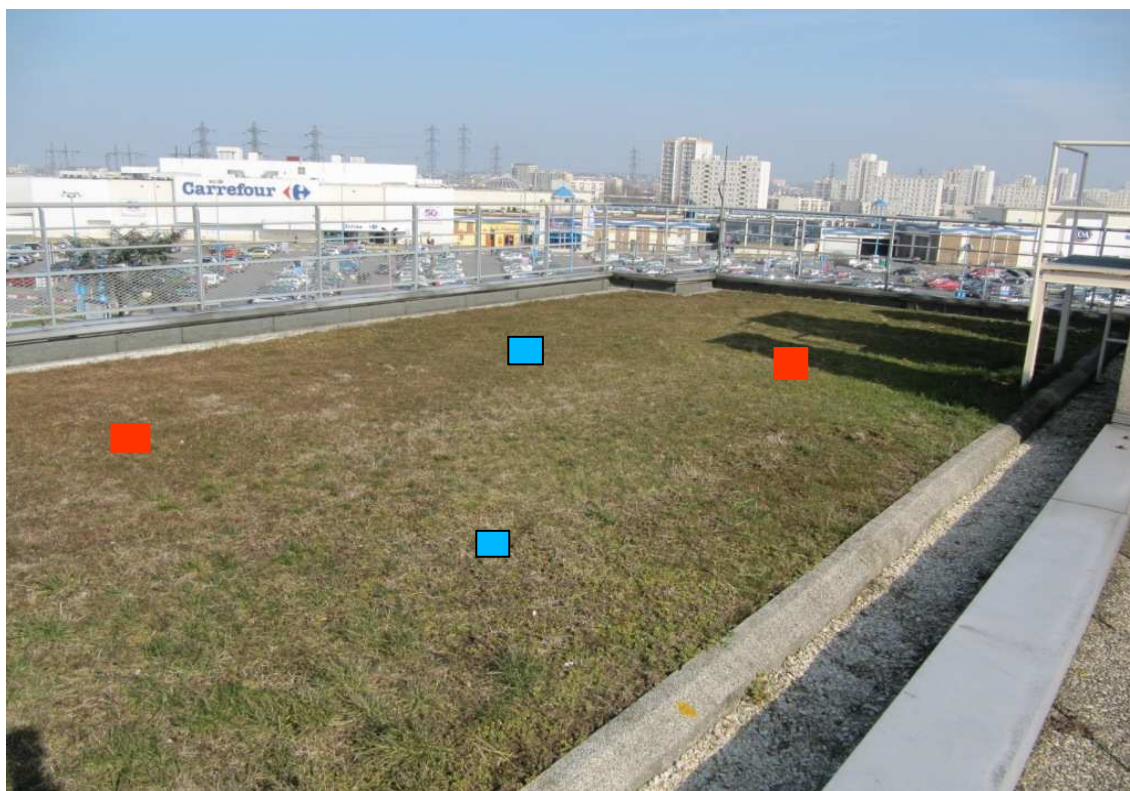
Figure 4 : Toiture végétalisée de la Direction de l'eau et de l'Assainissement du Conseil Général 93. Les carrés rouges indiquent l'emplacement des sondes HS10 (Decagon, USA) placées à -5 et -15 cm de profondeur dans le substrat et les carrés bleus indiquent l'emplacement des sondes ECHO-5 (Decagon, USA) placées à -5, -10 et -15 cm de profondeur dans le substrat
