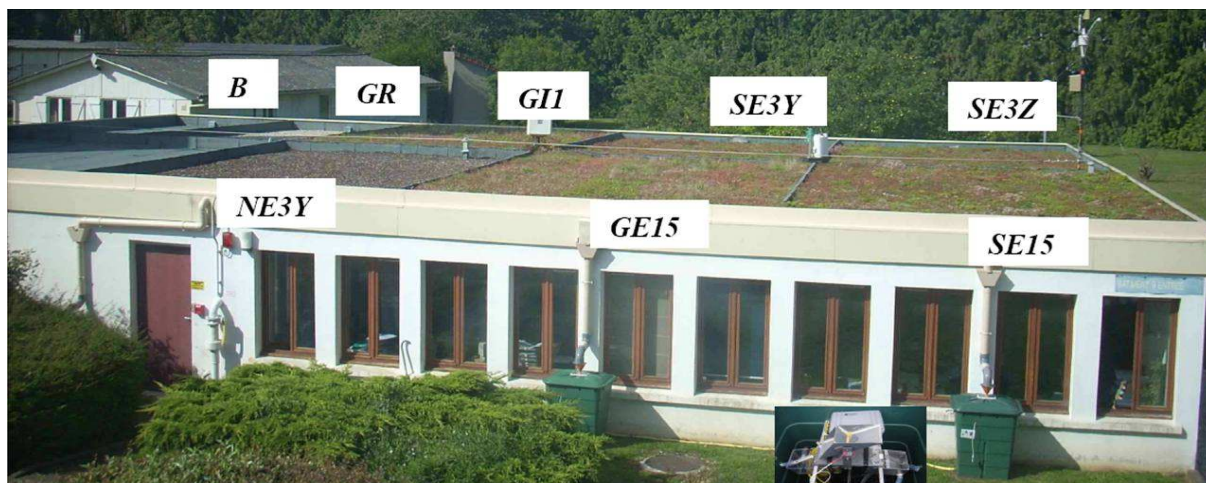
Figure 1 : Toiture végétalisée expérimentale du CETE IF.
