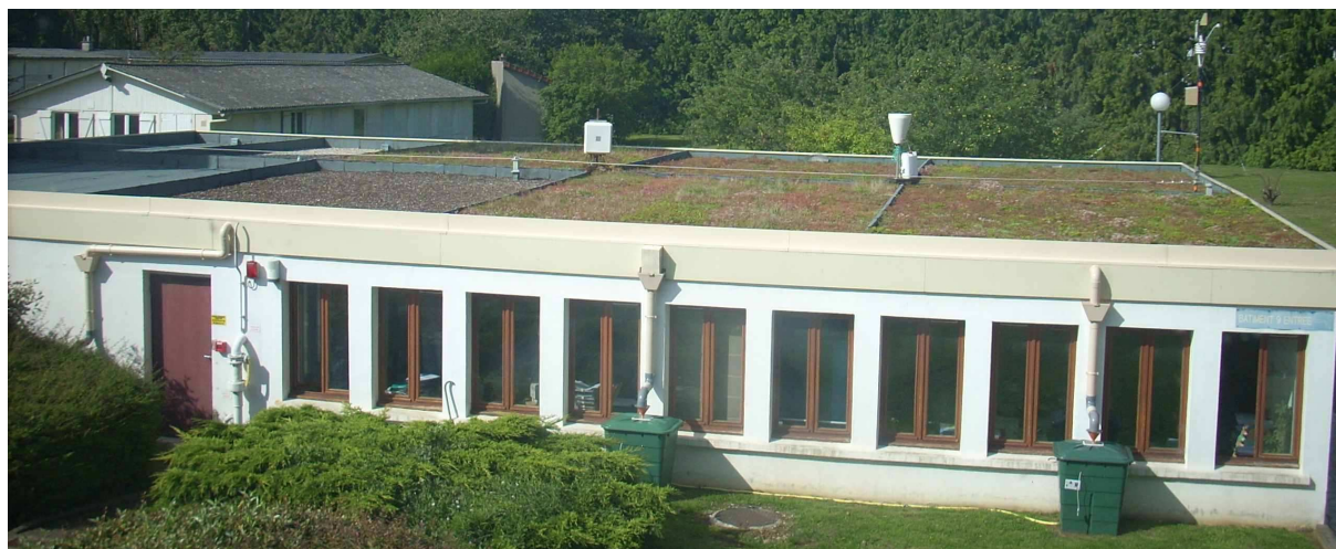
Figure 1 : Toiture végétalisée du CETE IF à Trappes. A droite du toit se trouve la station météo, à gauche de cette station, le pluviomètre. Les bacs verts au pied du bâtiment contiennent les augets pour la mesure des débits de ruissellement
