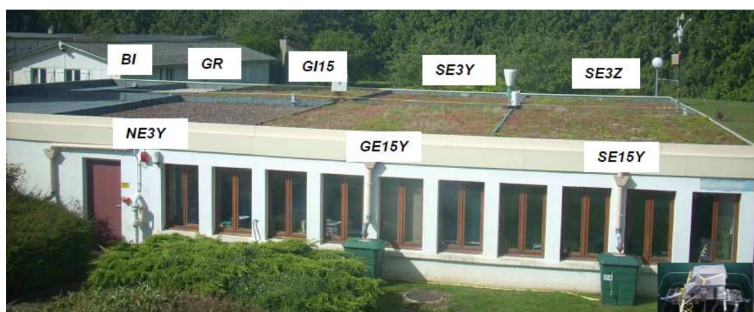
Figure 1: Photo de la toiture végétalisée expérimentale du CEREMA à Trappes avec les différents compartiments.
